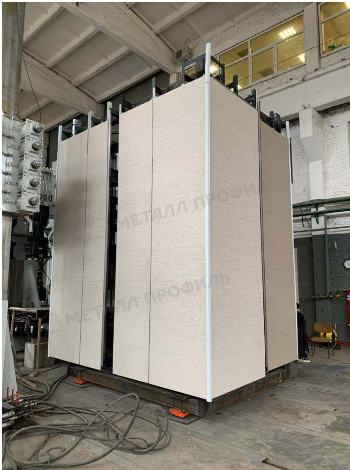
Рисунок 1.7. Общий вид стенда после завершения монтажа облицовочных панелей
